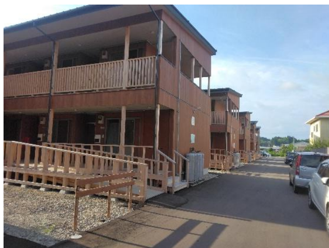
仮設の木造住宅
